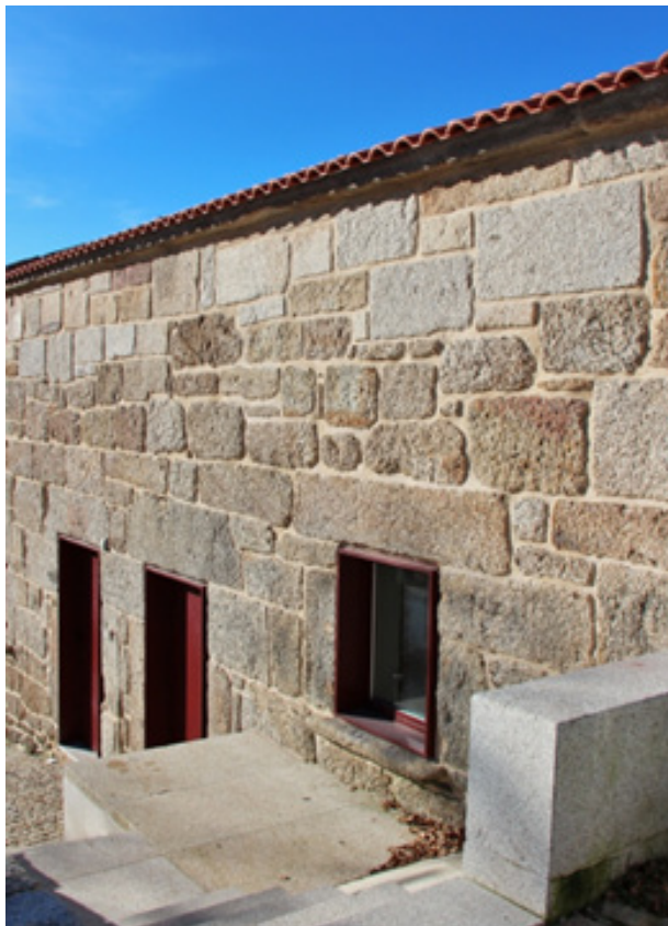
Andar inferior, zona de intervenção de Conservação e Restauro.
